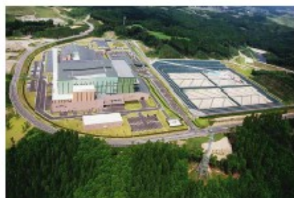
ゴミ発電施設
