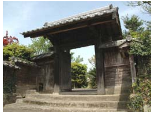
景観重要建造物【安藤家武家門】
