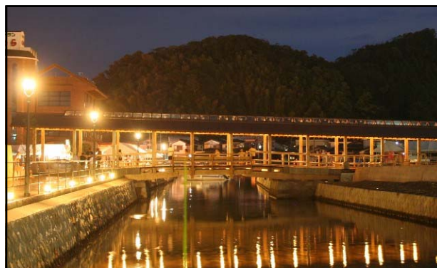
油津港堀川地区の港湾環境整備事業
