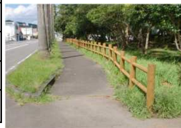
4-(1) 青島園地 防護柵改修
