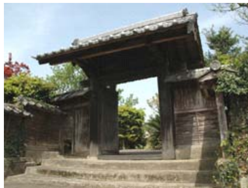
景観重要建造物【安藤家武家門】
