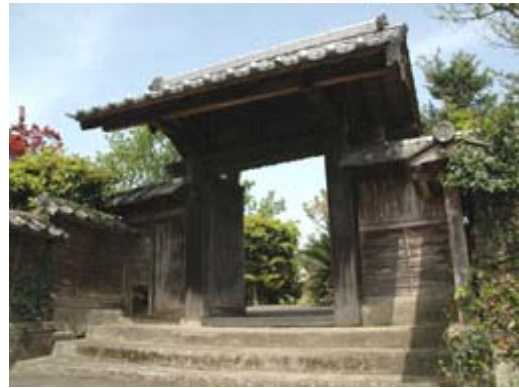
景観重要建造物【安藤家武家門】
