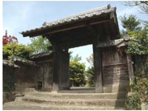
景観重要建造物【安藤家武家門】
