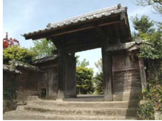
景観重要建造物【安藤家武家門】
