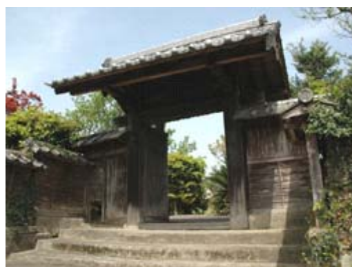
景観重要建造物【安藤家武家門】
