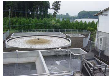
2-(1) 汚水処理施設
