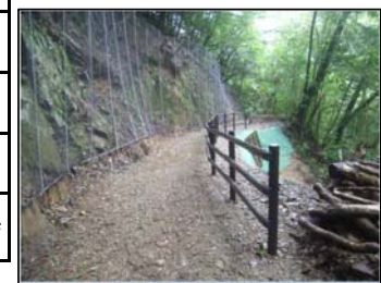
4-(3) 九州自然歩道尾鈴コース歩道橋
