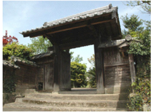
景観重要建造物【安藤家武家門】
