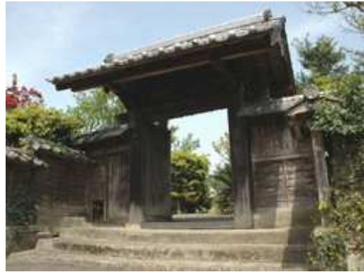
景観重要建造物【安藤家武家門】
