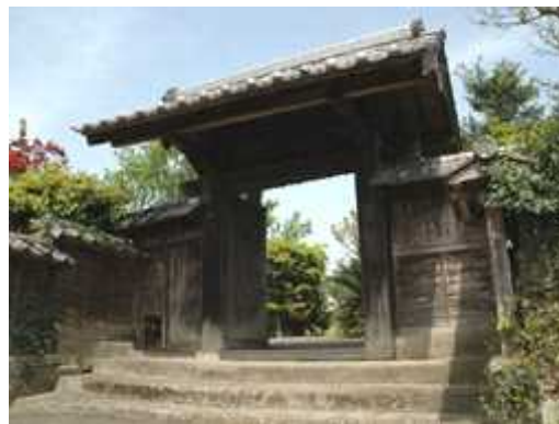
景観重要建造物【安藤家武家門】
