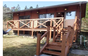
4-(1) 九州中央山地国定公園 矢立野営場整備
