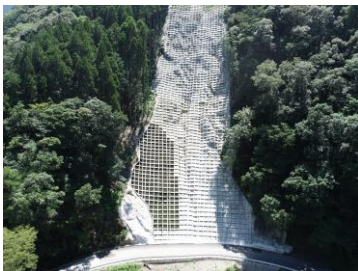
山腹工 治山ダム 1基
