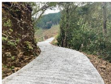
作業道路面工 231m 林道舗装工 2,162.1㎡
