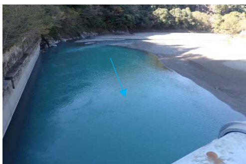
上流部（横野大橋） 上流部の河川はきれいな状態になっている。
