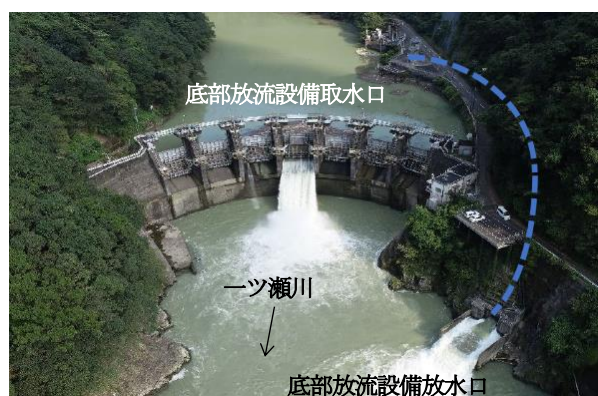
図 V-12 底部放流設備からの放流状況
