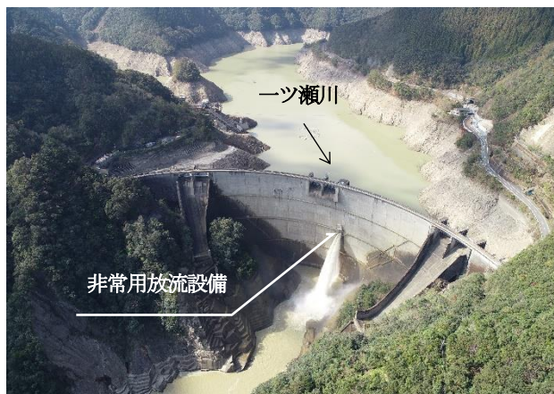
図 V-10 非常用放流設備からの放流状況
