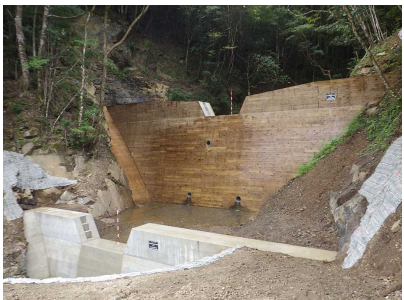
治山ダム 4基 山腹工
