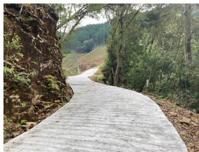
作業道路面工 150m 林道舗装工 8030.9㎡
