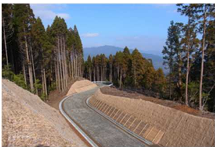
法面緑化工、路盤工（敷砂利） 林道開設事業（公共） の中で実施
