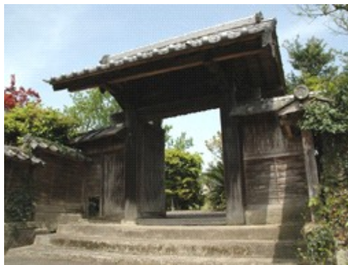
景観重要建造物【安藤家武家門】
