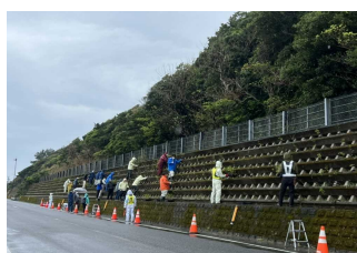
2-(1) ボランティア活動による 国道の植栽管理
