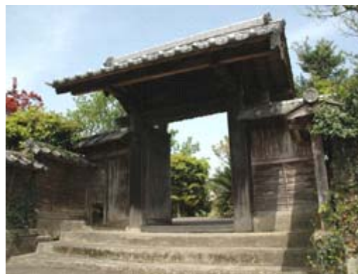
景観重要建造物【安藤家武家門】
