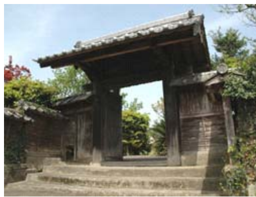
景観重要建造物【安藤家武家門】
